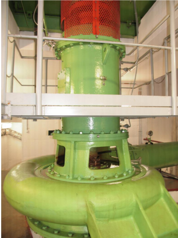
Obrázek 3: Vertikální čerpadlo HVBW 600
